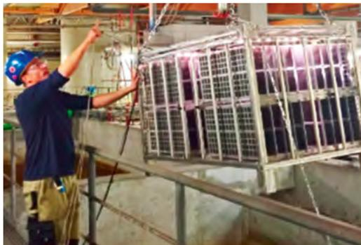
Abb.2: Installation von MOLLIK-Katalysator-Folien in die Kühlkreislaufzusatzwasseraufbereitung eines Braunkohlekraftwerkes (UNIPER Kraftwerke GmbH, Kraftwerk Schkopau)
